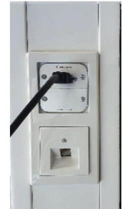
Das Monitor Verbindungskabel muss am Monitor in HDMI 2 und im Wandkanal oben in der Buchse eingesteckt sein.
