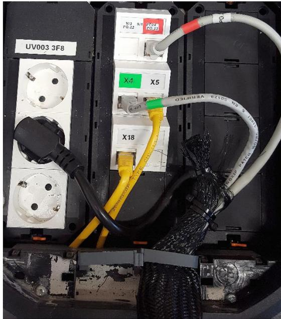
Pult am Bodentank angeschlossen
