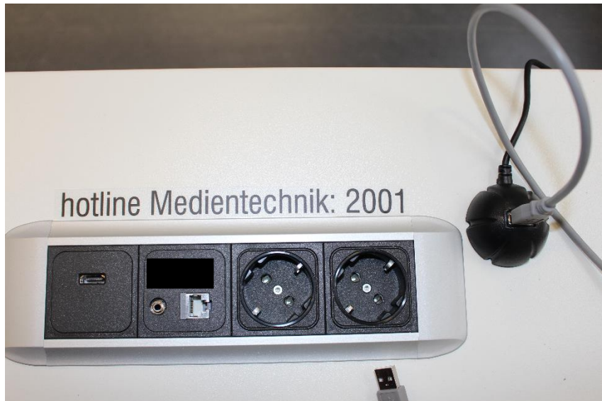
Vorhandene Anschlüsse (HDMI Kabel und Audiokabel bei Bedarf eigene verwenden)
