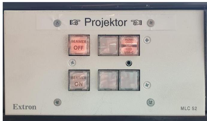
Der Anschluss der Geräte und die Bedienung des Projektors erfolgen über das Anschluss- und Bedienfeld im Brüstungskanal rechts vorne unter dem Fenster. Das Tastenfeld für die Bedienung von Licht und Jalousien befindet direkt daneben.
