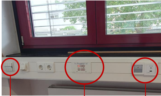
Licht und Jalousie Tastenbedienfeld Anschlussfelder
