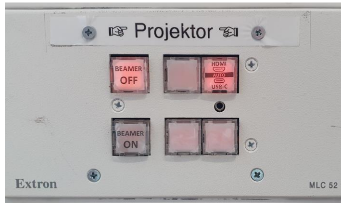
Bedienfeld für den Projektor rechts seitlich im Brüstungskanal
